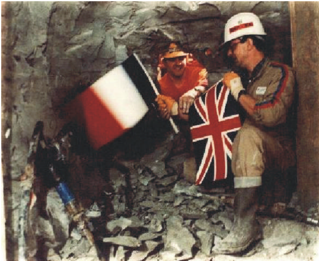
Abbildung 1: Grenzunterschreitung beim Bau des Eurotunnels (Quelle: [Tourguide 98])
